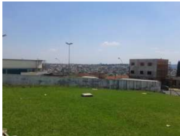
Figura 57: Vista de Telêmaco Borba do Reservatório Alto das Oliveiras.
