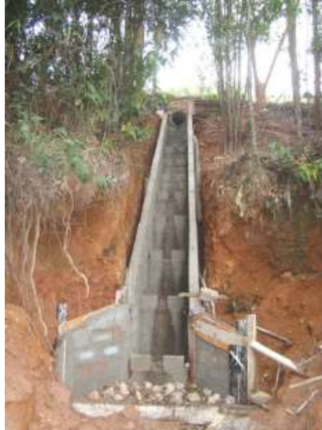
Figura 163: Dissipador de energia em degraus
