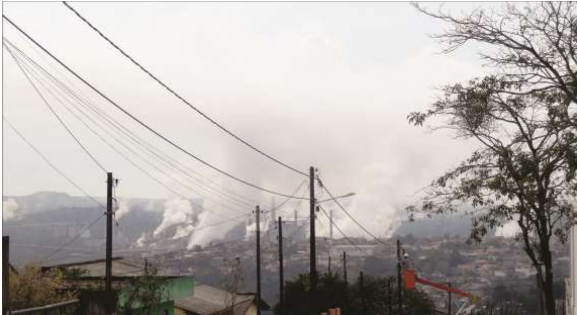
Figura 5: Vista de Telêmaco Borba a partir do Bairro Florestal com destaque ao fundo para a Unidade Fabril Monte Alegre das indústrias Klabin.
