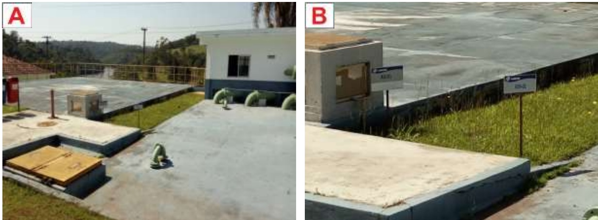
Figura 55: Reservatórios RSE-01 (A) e REN-02 (B) na Estação de Tratamento de Água.
