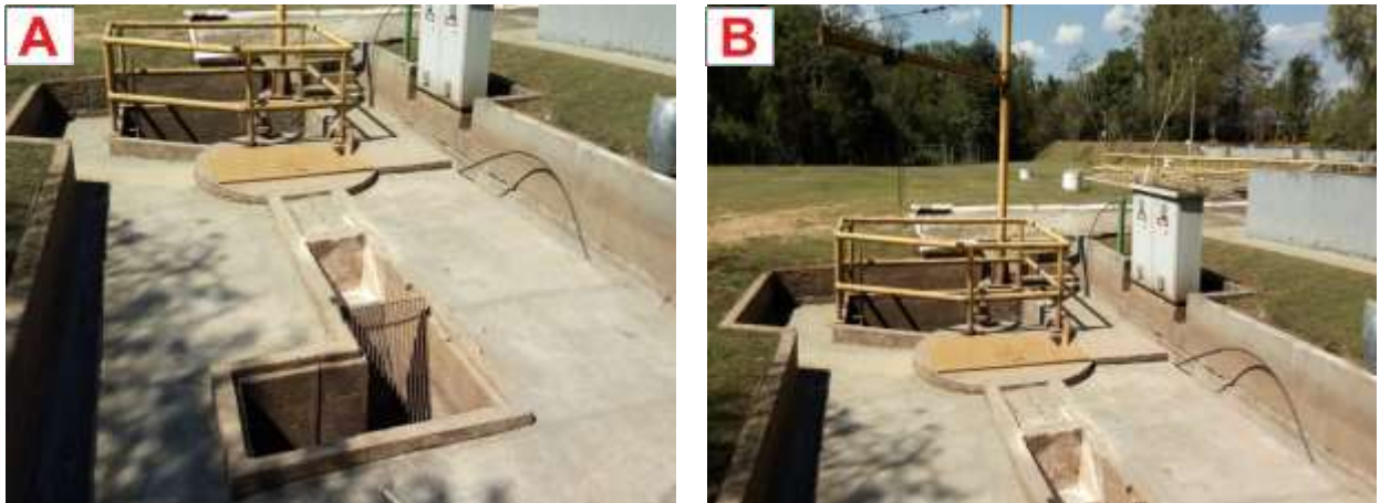
Figura 80: EEE Uvanaral, gradeamento (A); vista geral (B).
