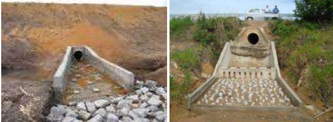
Figura 162: Dissipador de Energia em Caixa
