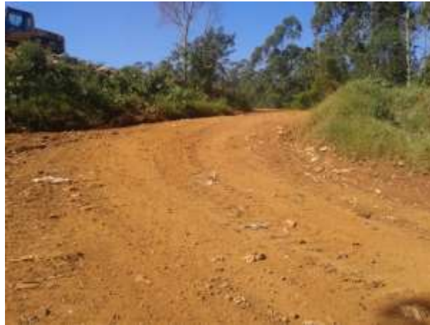
Figura 143: Estrada de acesso interno ao aterro sanitário.
