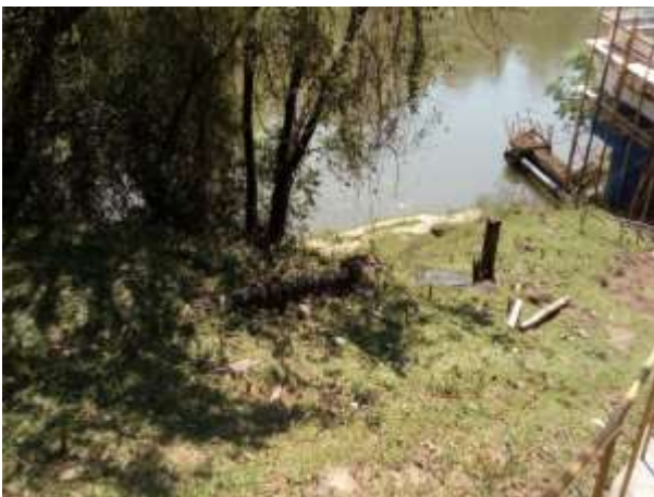
Figura 52: Primeiro trecho da adutora de água bruta.
