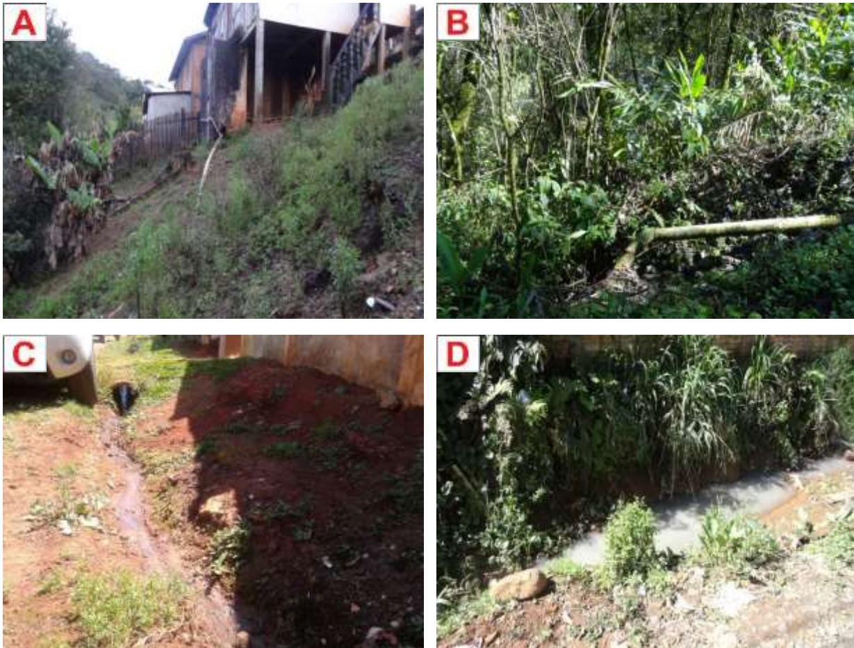
Figura 96: Possíveis ligações irregulares na rede de drenagem nos bairros Santa Rita (A) e (B), São João (C) e (D).
