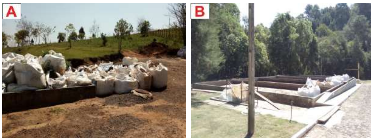
Figura 85: Lodo de esgoto ensacado aguardando envio pra UGL de Tibagi, ETE São Silvestre (A); ETE Uvaranal (B).
