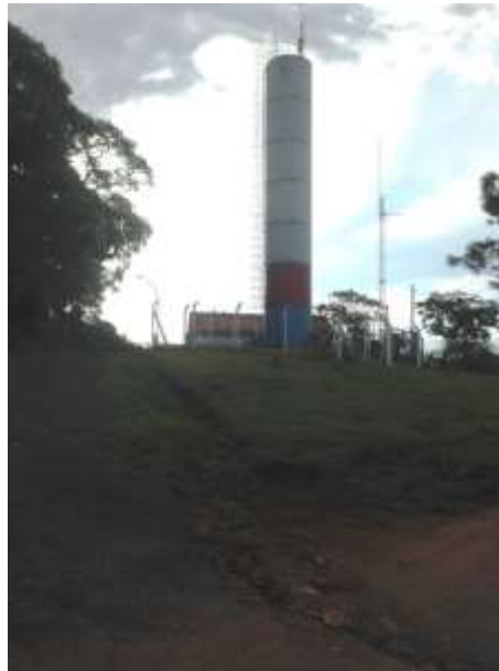
Figura 67: Reservatório Apoiado da Vila Rural.
