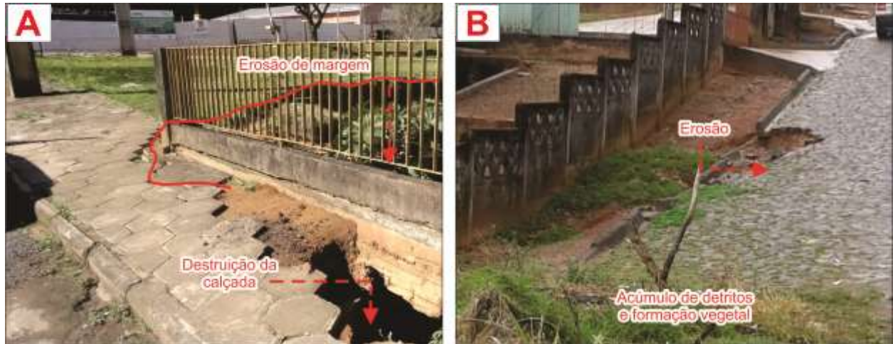
Figura 26: Problemas de drenagem nos bairros Jardim Kroll (A) e Vila Esperança (B).
