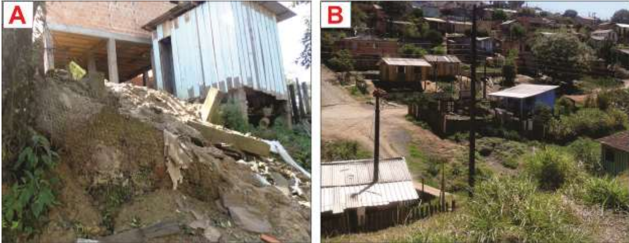
Figura 38: Exemplos de moradias situadas em áreas de risco como encostas declivosas e fundos de vale nos bairros Santa Rita (A) e São Silvestre (B).
