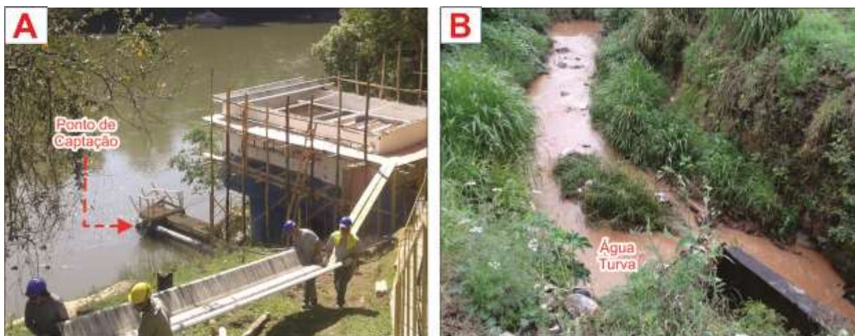
Figura 23: Obras na captação e situação da água no Arroio Limeira.
