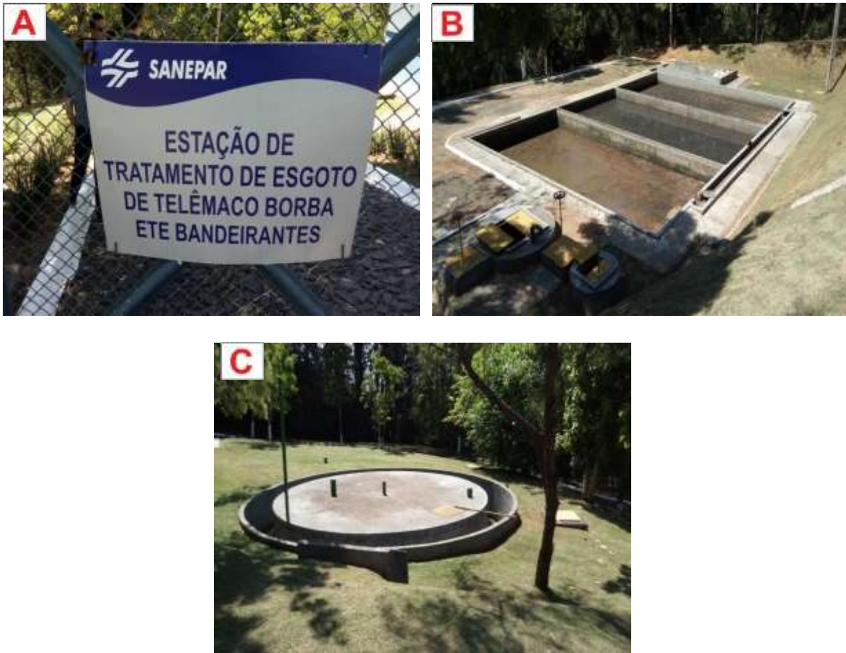
Figura 83: ETE Bandeirantes, detalhe da sinalização (A); leitos de secagem (B); RALF (C).
