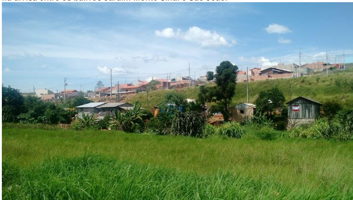
Figura 21: Vista da invasão em área de preservação permanente do Rio do Ouro, na divisa entre os bairros Jardim Monte Sinai e São João.
