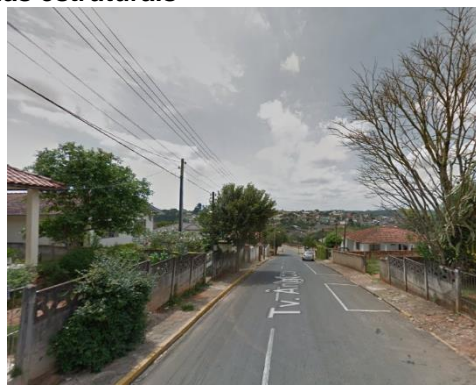
Travessa Angico: via com caixa insuficiente para a função estrutural.
