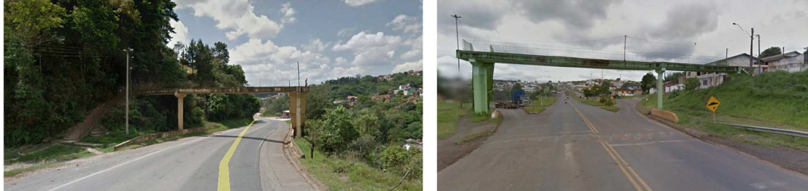
Figura 20: Passarelas sobre a Rodovia PR-160.
