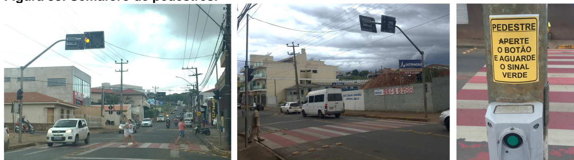
Figura 88: Semáforo de pedestres.
