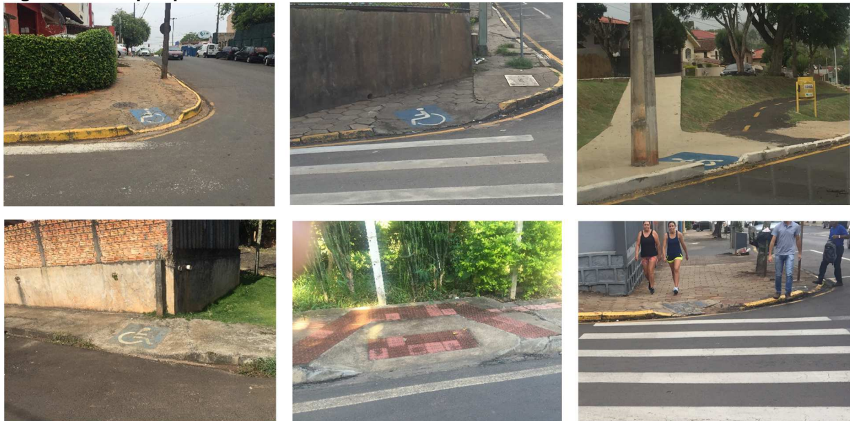
Figura 23: Rampas para a acessibilidade.
