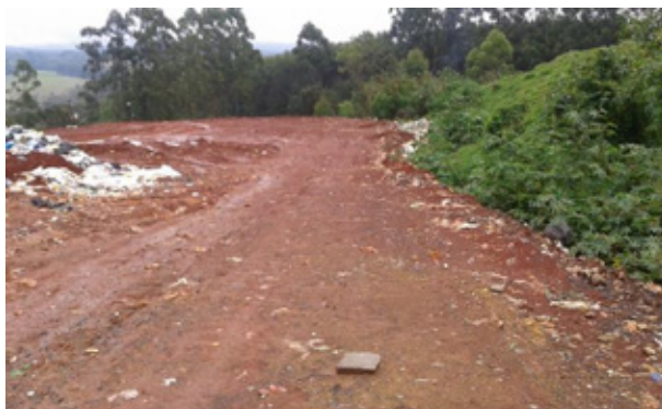
Foto – Frente de trabalho, acesso a célula de operação
