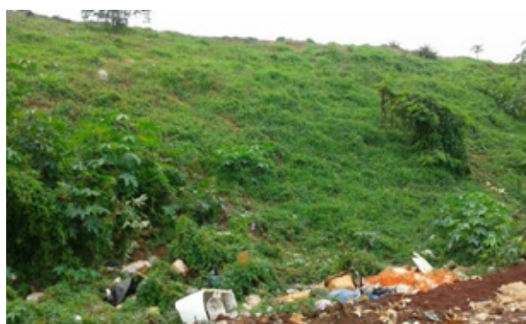
Foto – Aterro – talude lateral em consolidação
