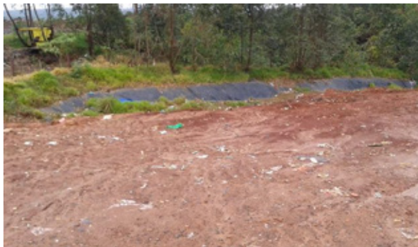
Foto – Detalhe do aterro, manta de impermeabilização
