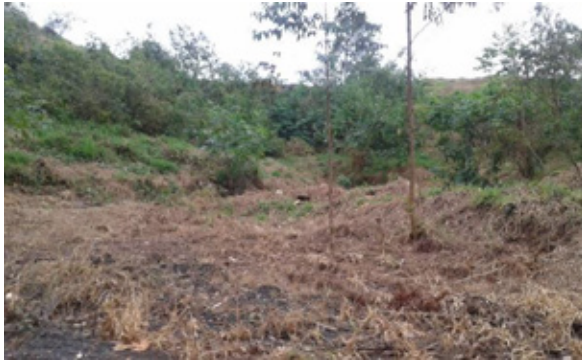
Foto – Aterro – talude lateral, plantio de vegetação, lateral em consolidação
