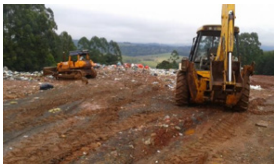
Foto – Detalhe da frente de trabalho da célula
