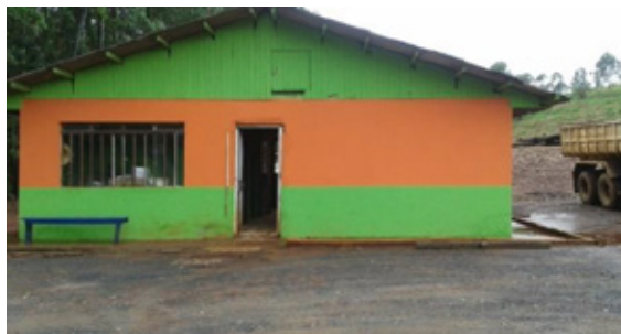
Foto – Escritório, acesso e balança do aterro
