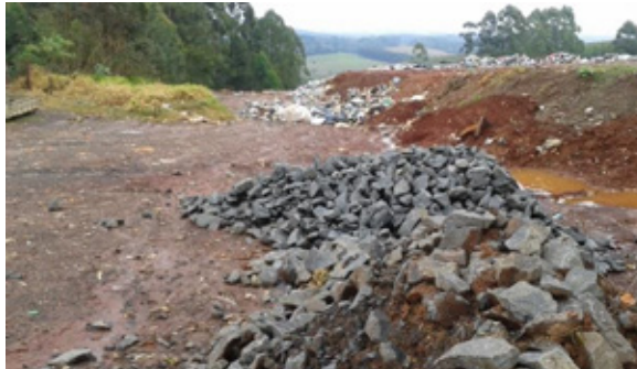
Foto – Preparação de terreno para recirculação de chorume (bombeamento)
