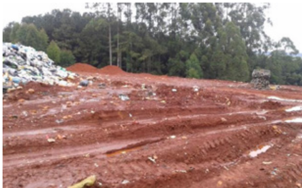
Foto – Frente de trabalho, célula e drenagem vertical de gases
