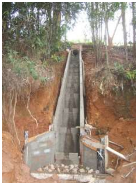
Figura 163: Dissipador de energia em degraus
