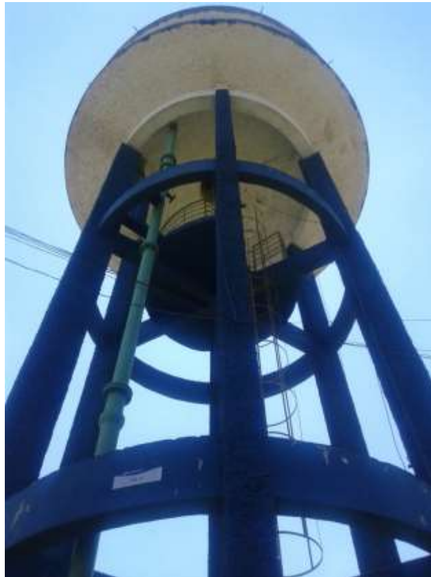
Figura 56: Reservatório Elevado (REL-02) – Alto das Oliveiras
