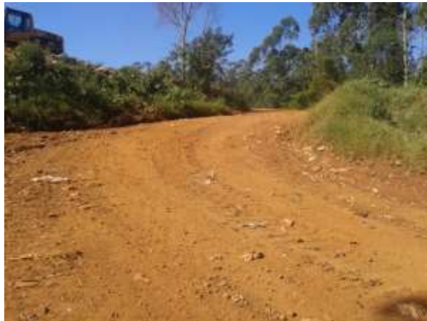
Figura 143: Estrada de acesso interno ao aterro sanitário.
