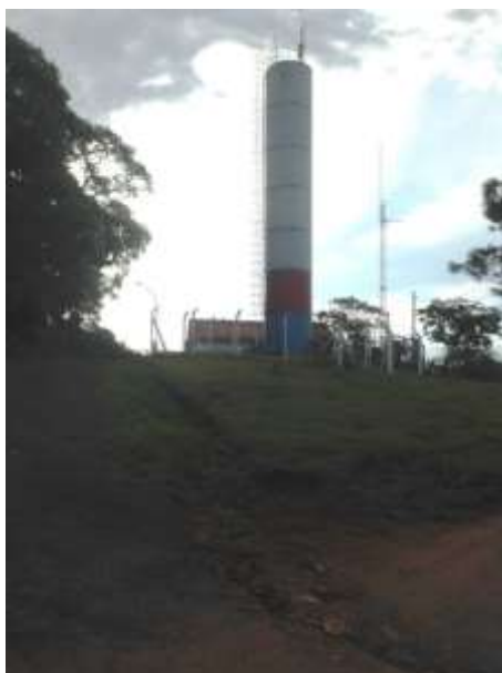
Figura 67: Reservatório Apoiado da Vila Rural.
