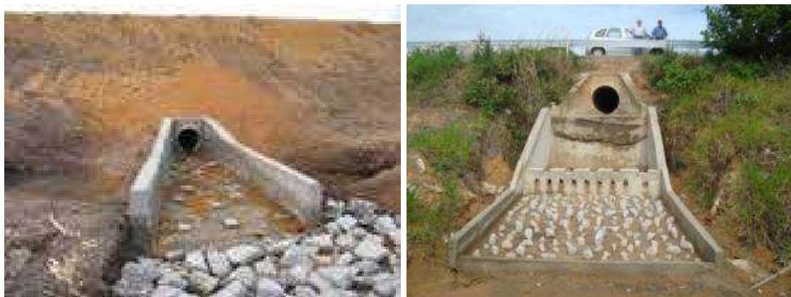
Figura 162: Dissipador de Energia em Caixa
