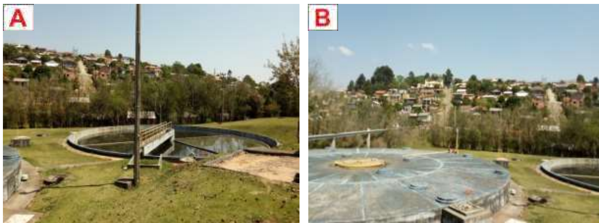
Figura 82: ETE São Silvestre, vista geral (A); detalhe do RALF (B).
