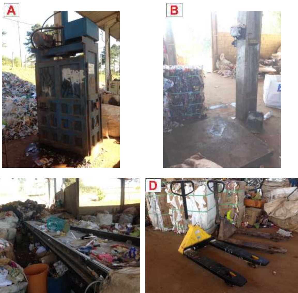
Figura 146: Equipamentos da Cooperativa Ambiental de Telêmaco Borba – Prensa hidráulica (A), balança (B), esteira (C) e carrinho para carregar material (D).
