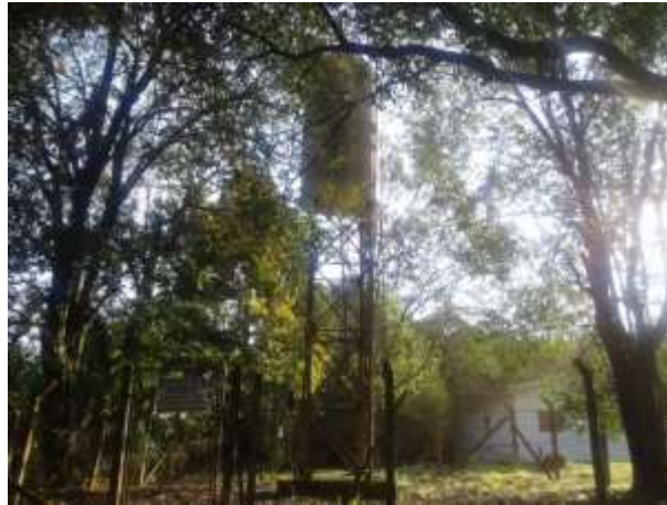
Figura 60: Reservatório Elevado (REL-03) – Triângulo.
