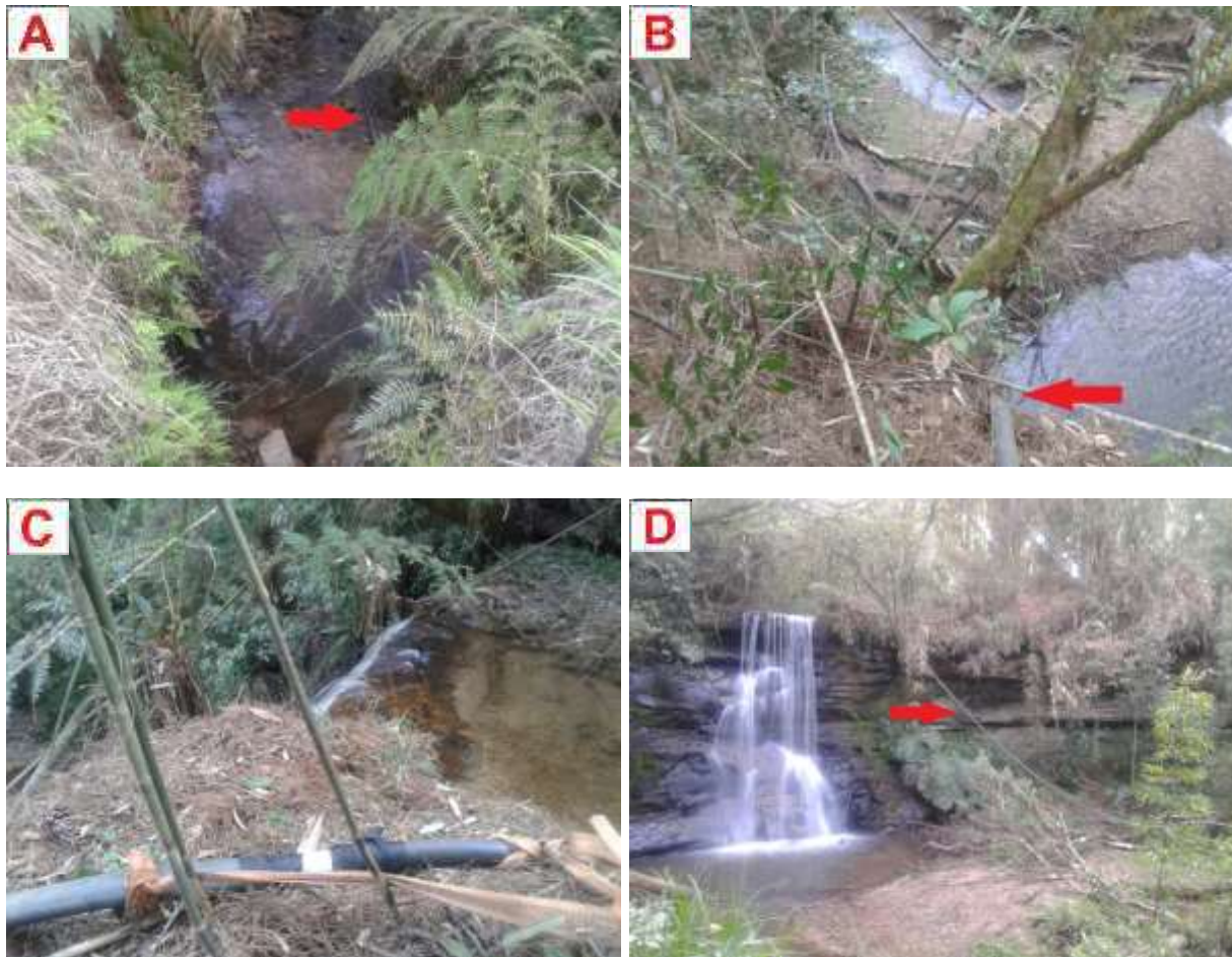
Figura 158: Mangueira de Captação Superficial – mangueira antes da travessia pela estrada (A); mangueira antes da cachoeira (B) e (C); mangueira após a cachoeira (D).
