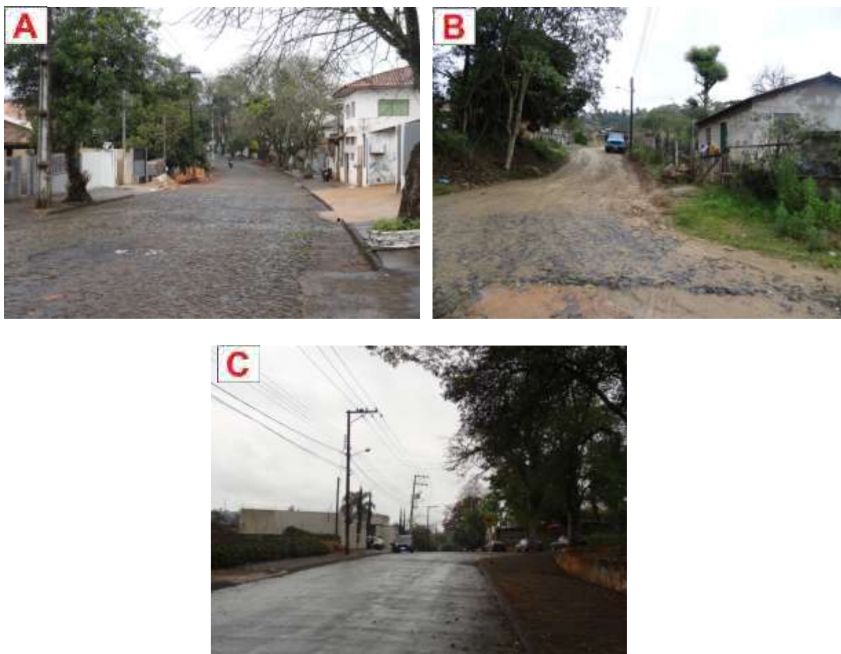
Figura 90: Tipos de pavimento em Telêmaco Borba - Polidrico (A); Cascalho (B); Asfalto (C).
