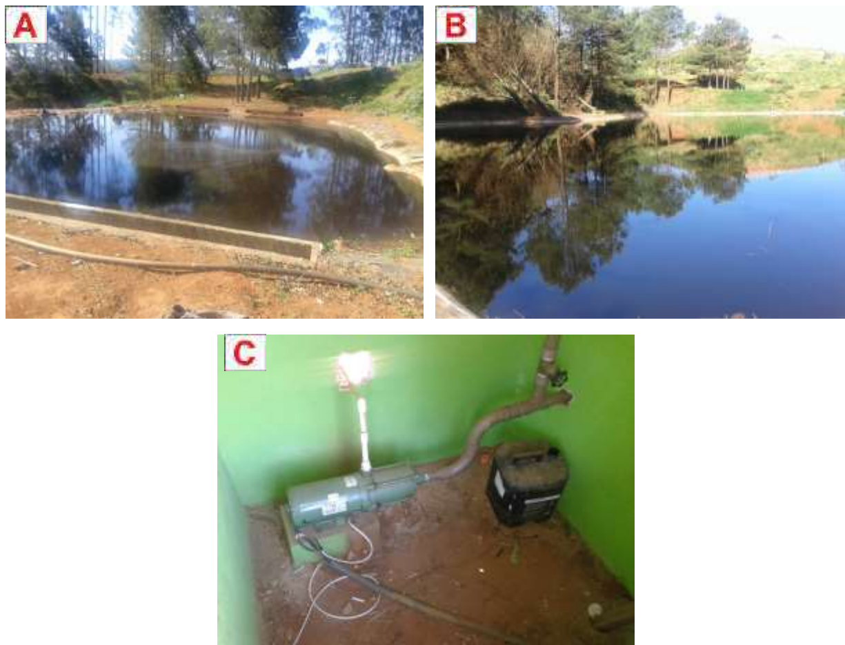
Figura 137: Lagoas anaeróbia (A) e facultativa (B) de tratamento de chorume e bomba de recirculação (C) do aterro sanitário.
