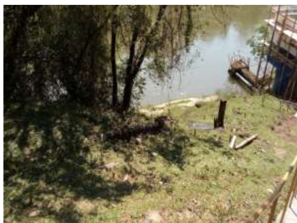
Figura 52: Primeiro trecho da adutora de água bruta.
